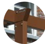
🔍 Pillar beam junction Nodo trave pilastro Nœud poutre pilier Verbindungsknoten von Balken/Pfeiler Nudo viga columna Verbinding balk staander
